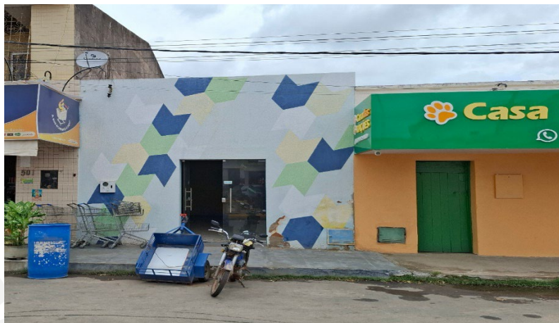
Figura 1: FACHADA DO PREDIO
