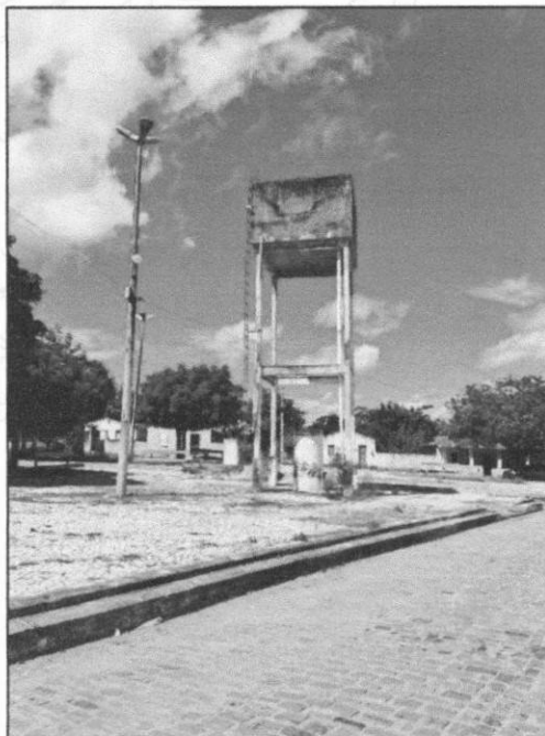
Figura 5: Vista lateral caixa d'água
