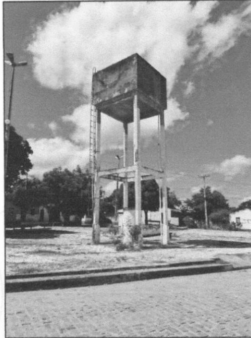
Figura 4: Vista frontal caixa d'água
