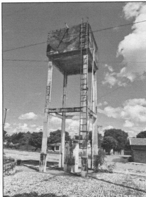
Figura 2: Vista fundo caixa d'água
