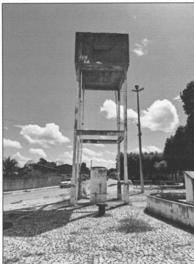
Figura 1: Vista lateral caixa d'água
