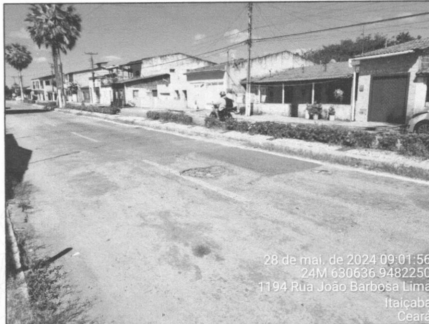
Figura 10: Trechos pavimentação esburacada
