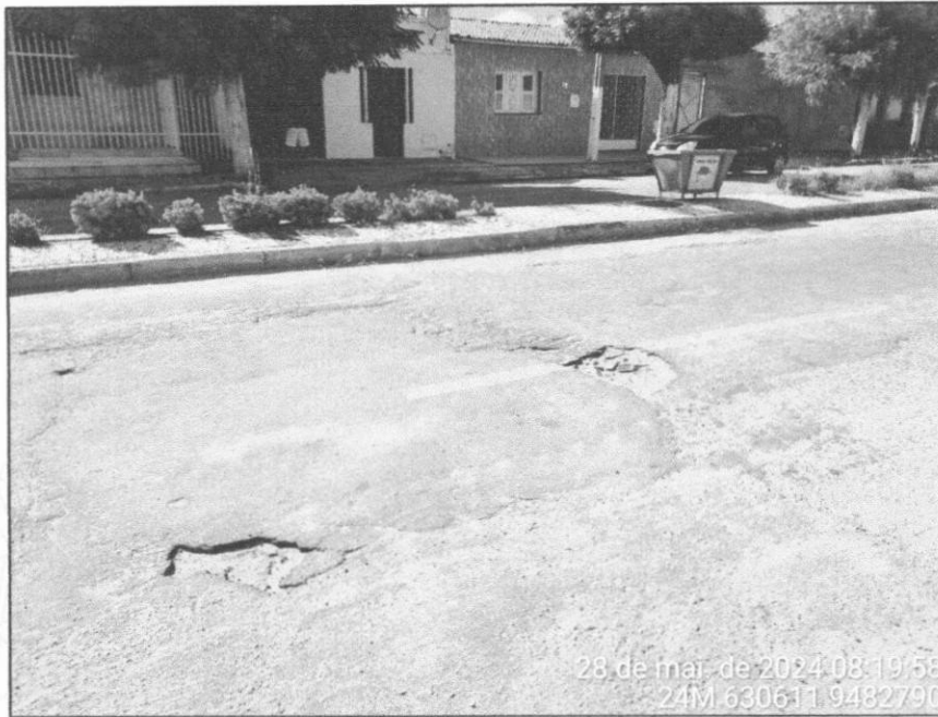
Figura 4: Trechos pavimentação esburacada
