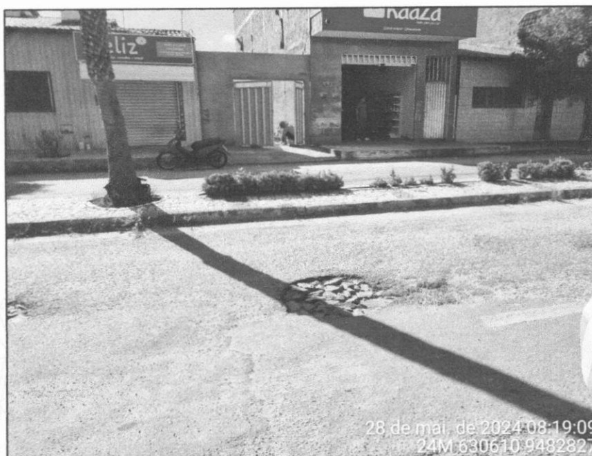
Figura 6: Trechos pavimentação esburacada
