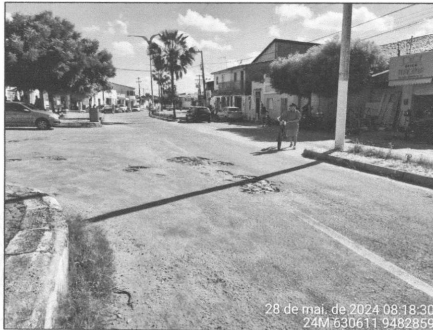
Figura 8: Trechos pavimentação esburacada
