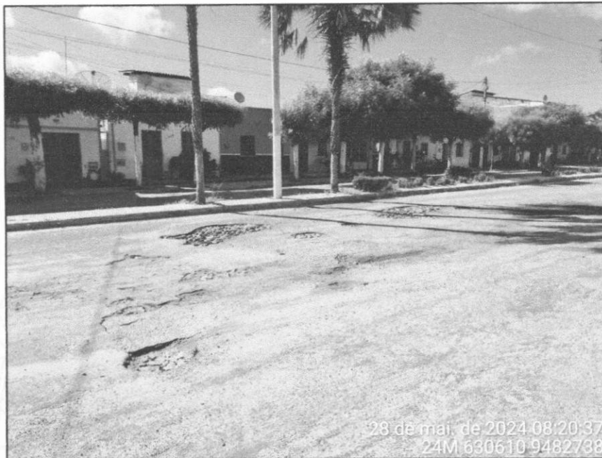
Figura 2: Trechos pavimentação esburacada
